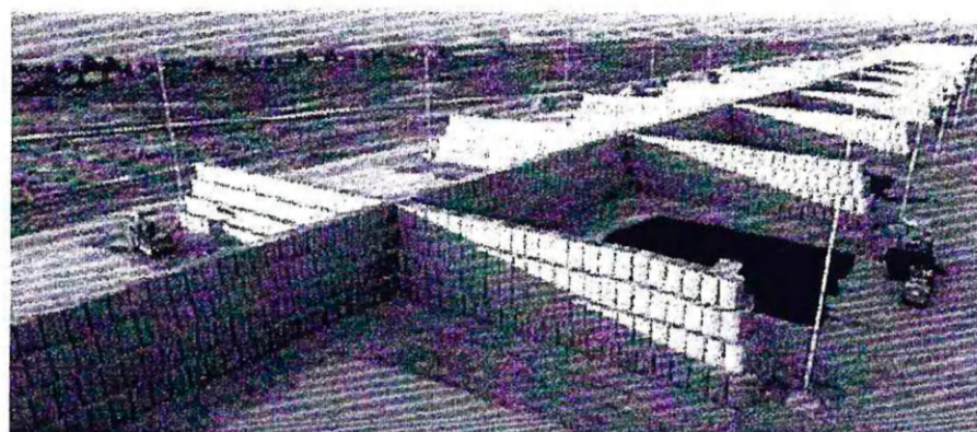
Рис.1 Вариант установки габионов насыпного типа
